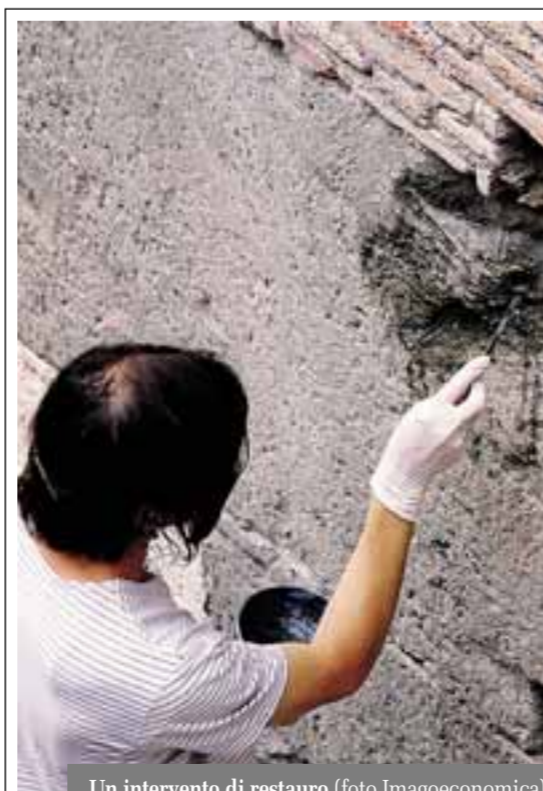
Un intervento di restauro (foto Imagoeconomica)
